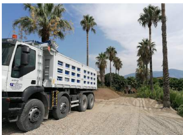
Realizzazione dei percorsi interni
